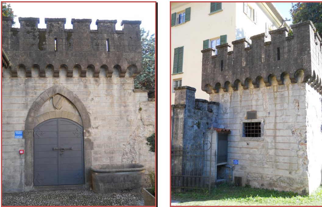
Figura 19 - Vista della Centrale Termica da recuperare
