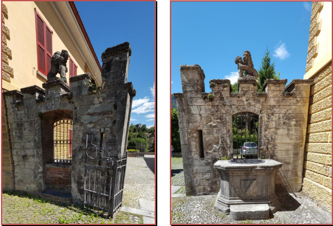
Figura 20 - Vista del muro di ingresso annesso alla Centrale Termica - Prospetti Est ed Ovest
